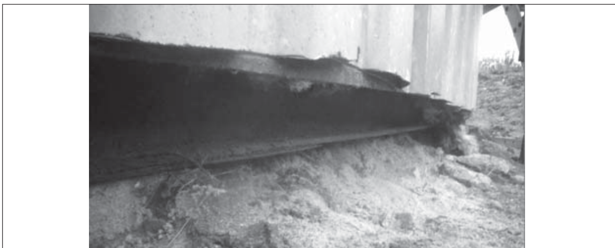
Рис. 1. Слоистая коррозия окрайки дна резервуара
