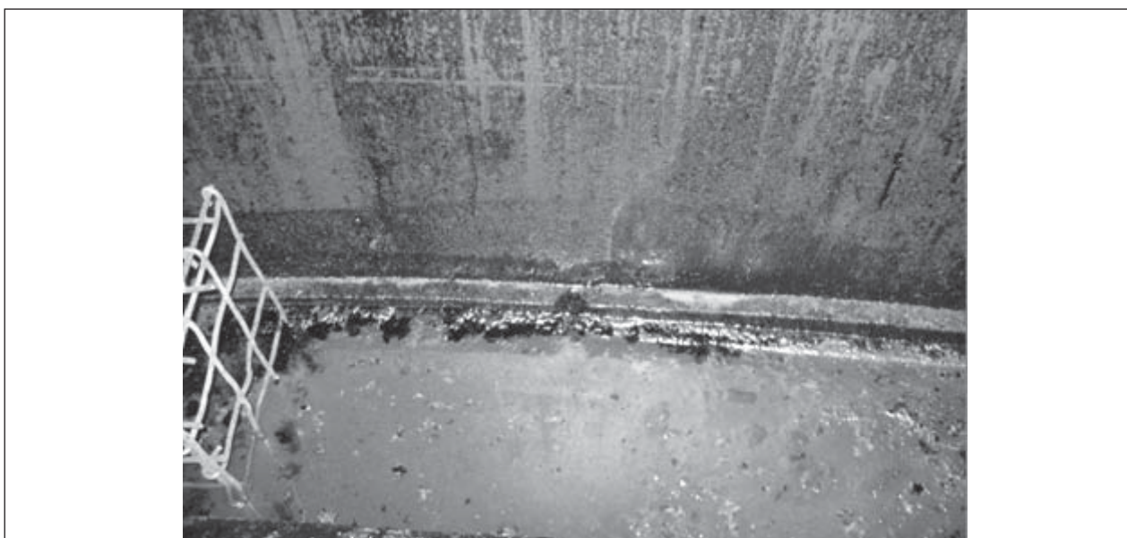
Рис. 2. «Уторное кольцо» из развальцованного швеллера
